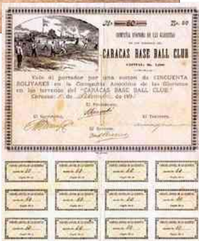
Bonos para construcción de tribunas Stand del Este, 1895
